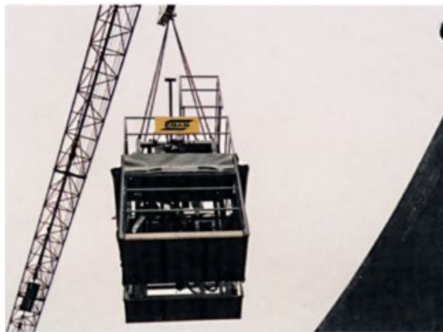
Dwustronne urządzenie Circotech unoszone do pozycji roboczej.
